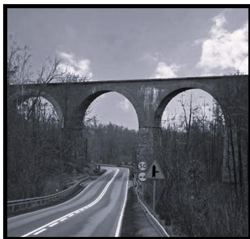
Ryc. 4. Wiadukt wąskotorowy w Buszkowie koło Koronowa
