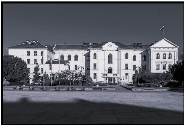
Ryc. 1. Budynek dawnego Kolegium Jezuickiego, obecnie ratusz
